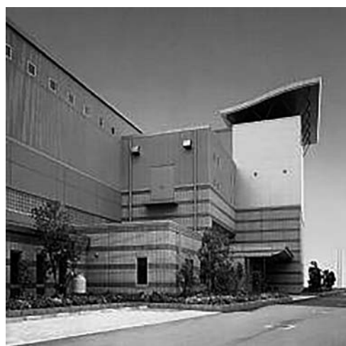
西部リサイクルプラザ（出典：広島市ホームページ）
